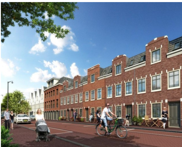
Impressie nieuwbouw Plaspoelstraat
