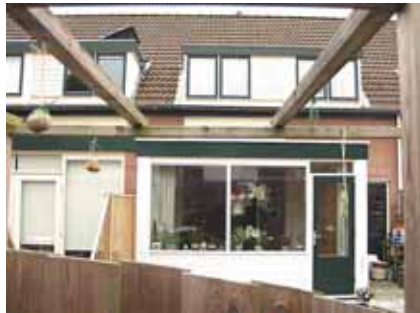
uitbouw aan achtergevel, vergunningvrij mits niet dieper dan 250 cm vanaf de achtergevel.
