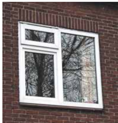
links nog de originele houten raampartij, het kunststof kozijn rechts mist profilering en lijkt daardoor dikker, het klepraam ligt lelijk op het kozijn, het geheel is te fel hagelwit.
