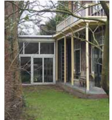
deze aanbouw is licht vergunningplichtig, is immers dieper dan 250cm vanaf de zijgevel en steekt ook uit voorbij de achtergevel. De platte kozijnprofieling is niet in overeenstemming met de architectuur van het hoofdgebouw, voldoet niet aan redelijke eisen van welstand
