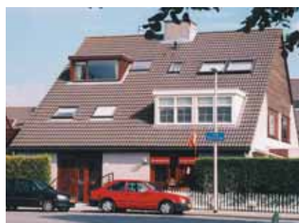
Deze dakkapellen op hetzelfde dakvlak missen een eenheid in plaatsing en afmetingen
