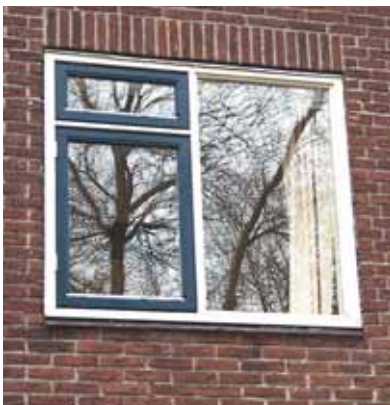
links nog de originele houten raampartij, het kunststof kozijn rechts mist profilering en lijkt daardoor dikker, het klepraam ligt lelijk op het kozijn, het geheel is te fel hagelwit.
