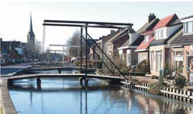
het historische type metalen ophaalbrug met houten wegdek is "trendsetter" bij eventuele vervangingen in het kernlint van Stompwijk
