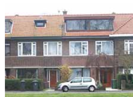
deze dakkapel aan de voorzijde is te breed, 60% van de gevelbreedte is welstandshalve acceptabel
