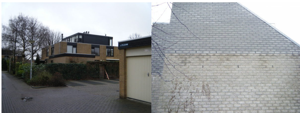
Figuur 2: Linker foto: voor vleermuizen ongeschikte bebouwing in Essesteijn. De dakranden zijn grotendeels afgewerkt met aluminium profielen. De houten delen zitten strak op de muren, spleten zijn afgedicht. Rechter foto: Wel geschikte bebouwing in de wijk Essesteijn met open stootvoegen.
