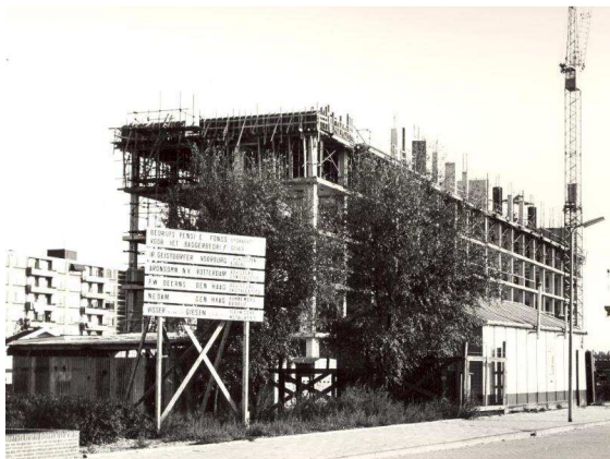
Zürich-kantoor in aanbouw in 1970
