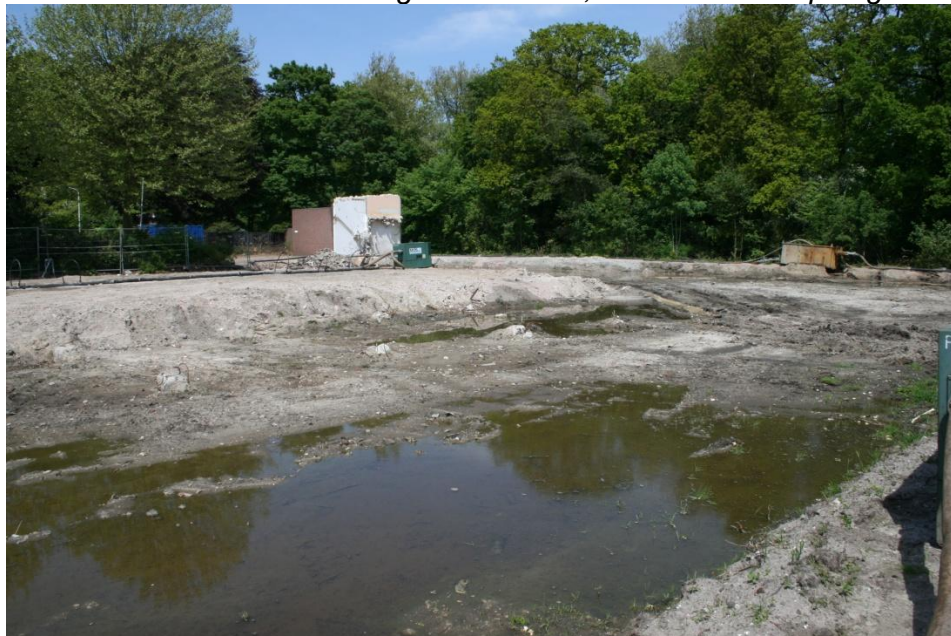
Foto 2: terreinkarakter met stagnerend water, bouwrestant en parkgebied
