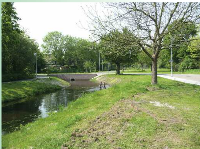
2012 duiker verwijderd en watergang aangelegd.
