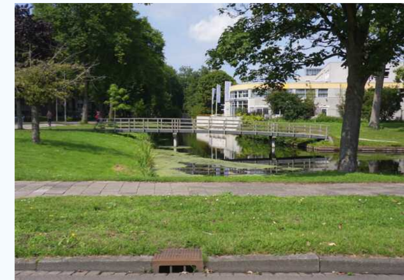
Figuur 3-1: Meer ruimte voor water: een brug in plaats van een duiker
