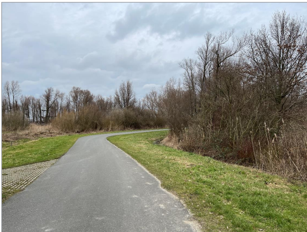
Westkant van gebied 1 met toegangsweg voor autoverkeer.
