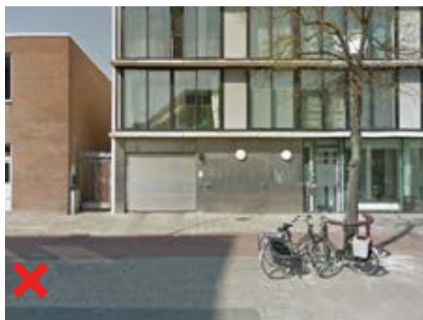
Toegang parkeergarage niet als kale blinde muur
