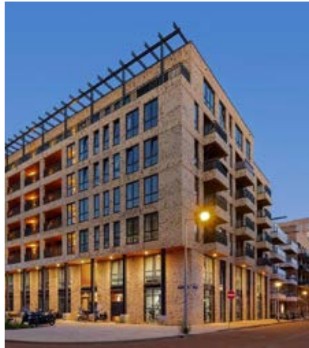
Inpandige fietsenstalling naast de hoofdingang - Lieveu, Amsterdam, KENK architecten
