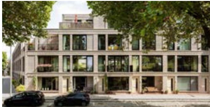
Horizontale geleiding door banden in het gevelontwerp - The Hudsons, Rotterdam, Orange Architects
