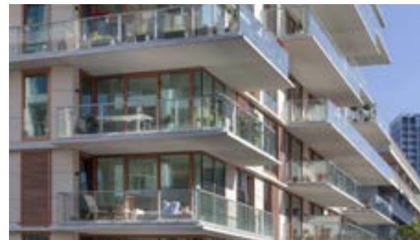
Variatie in materialen zorgt voor diepte en open uitstraling. Sterke horizontale geleding - The Row, Amsterdam, DP6
