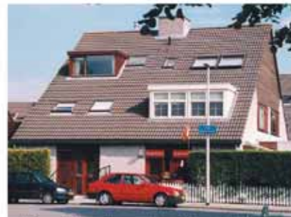
Deze dakkapellen op hetzelfde dakvlak missen een eenheid in plaatsing en afmetingen
