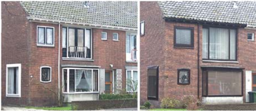
de linker woning heeft nog de originele jaren '50 raampartijen, rechts is te grof gemoderniseerd, voldoet niet aan redelijke eisen van welstand
