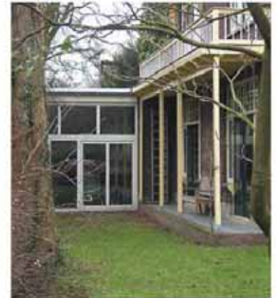
deze aanbouw is licht vergunningplichtig, is immers dieper dan 250cm vanaf de zijgevel en. De platte kozijnprofilering is niet in overeenstemming met de architectuur van het hoofdgebouw, voldoet niet aan redelijke eisen van welstand
