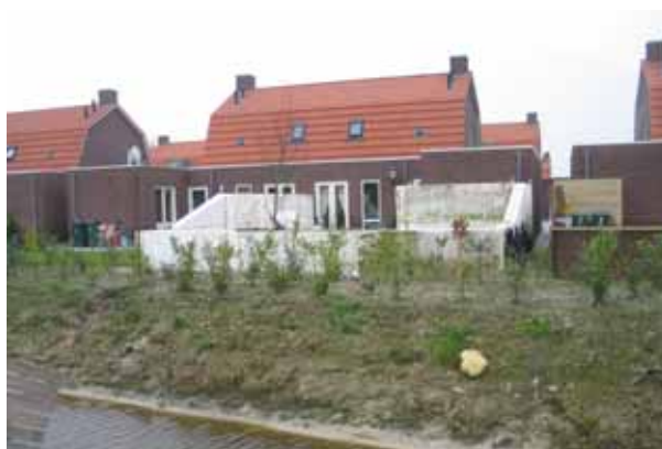
Te provisorische en onvoldoende op de woning afgestemde erfafscheiding.
