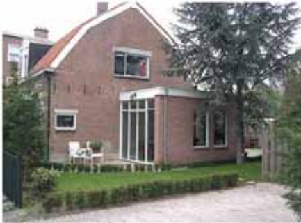
uitbouw aan zijgevel, niet op een straathoek, vergunningvrij mits niet dieper dan 250 cm vanaf de zijgevel.
