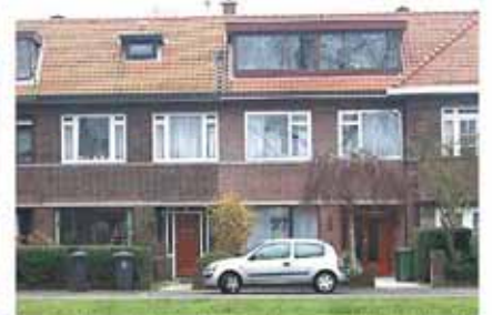
deze dakkapel aan de voorzijde is te breed, 60% van de gevelbreedte is welstandshalve acceptabel
