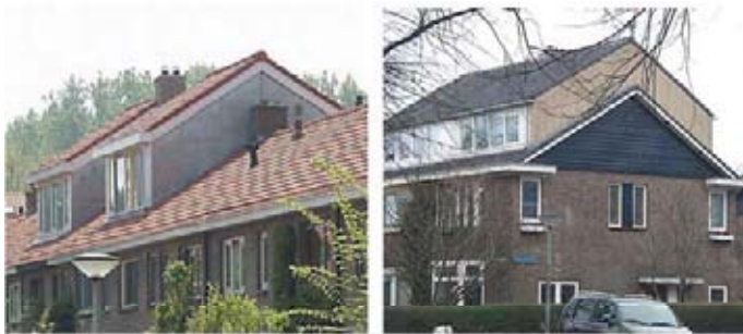
de nokverhoging links is goed gematerialiseerd, rechts is baksteen toegepast voor de zijkant, boven een topgevel die al was afgerond in hout. Het resultaat oogt onevenwichtig en voldoet welstandshalve niet voor wat betreft de materialisering.
