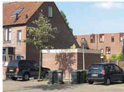
voldoet niet, te gesloten aanbouw
