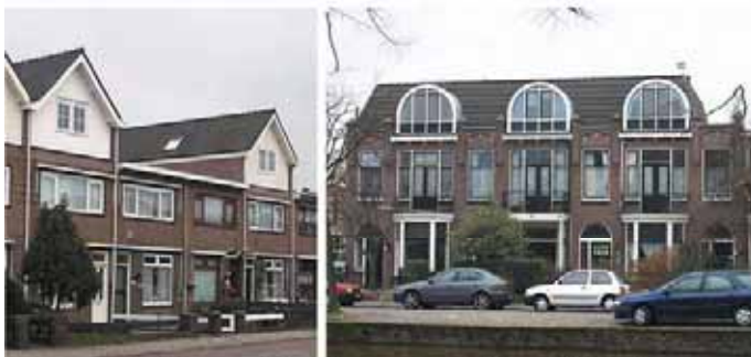
twee voorbeelden van dakopbouwen waarbij een hele kaplaag wordt gerealiseerd die karakter toevoegt aan de voorheen plat afgedekte woningen.
