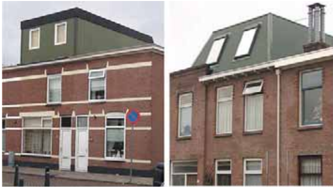
opbouwen met te grove vorm en materiaalgebruik (metaalgolfplaat)
