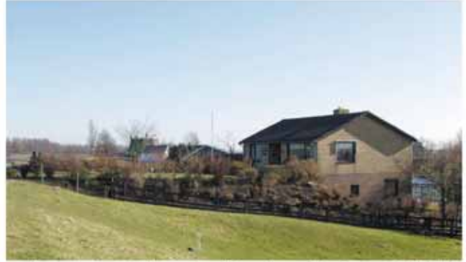
deze woning staat op ruime afstand van de kruin van de dijk. Het voorerf is opgehoogd tot aan de kruin. Dit "aanterpen" verstoort zowel de openheid van het landschap als wel het kenmerkende doorgaande dijkprofiel en wordt door welstand afgewezen.
