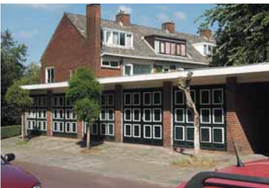
garages en bergingen zijn in samenhang met de architectuur en het straatbeeld. Eenheid van kleur in het schilderwerk is hier cruciaal voor de visuele samenhang
