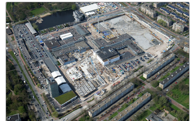
Situatie bouw april 2018
