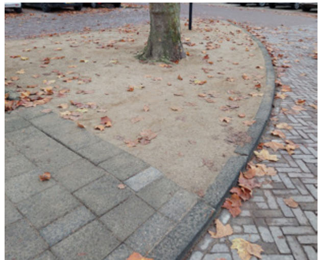
Halfverharding onder bomen is een alternatieve bestrating die de groeiplaats ten goede komt.
