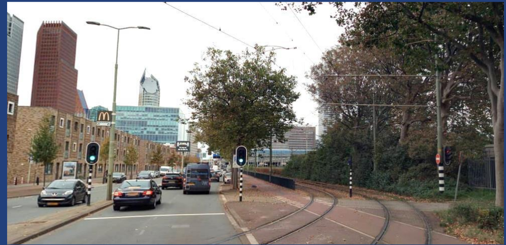
Figuur 3.7: Huidige tramsporen Lekstraat (kijkrichting vanaf Scheldeplein richting Den Haag Centraal).
