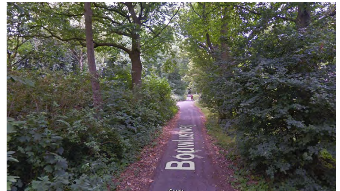
Bestaande situatie Bouwlustweg - achterstallig onderhoud, opschot en asfalt
