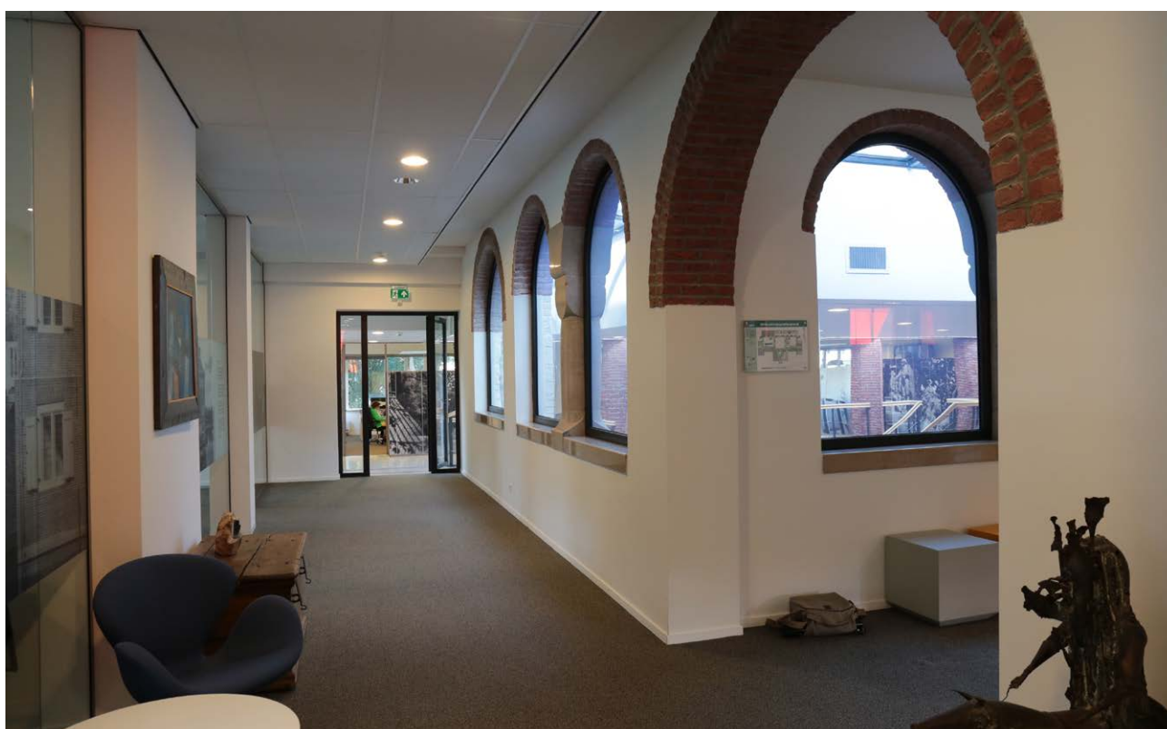
afb. 49: Huidige toestand. De vier getoogde vensters naast deze hoek waren ook oorspronkelijk binnenramen - met zicht op het trappenhuis. Vandaag maken ze deel uit van een brandscheiding.
