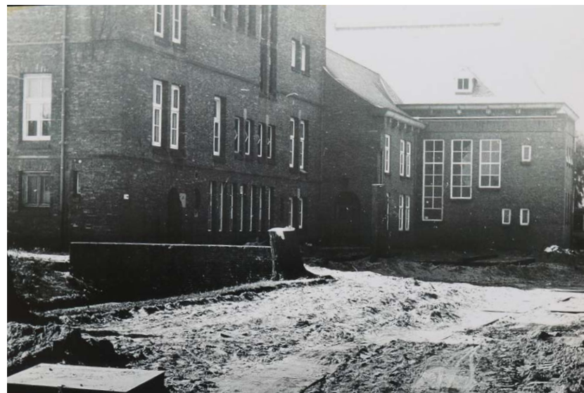
afb. 53: 1978, de fietsenberging aan de achterzijde is afgebroken [3]. De raampartij langs het trappenhuis (met plat dak) is nu goed in beeld.
