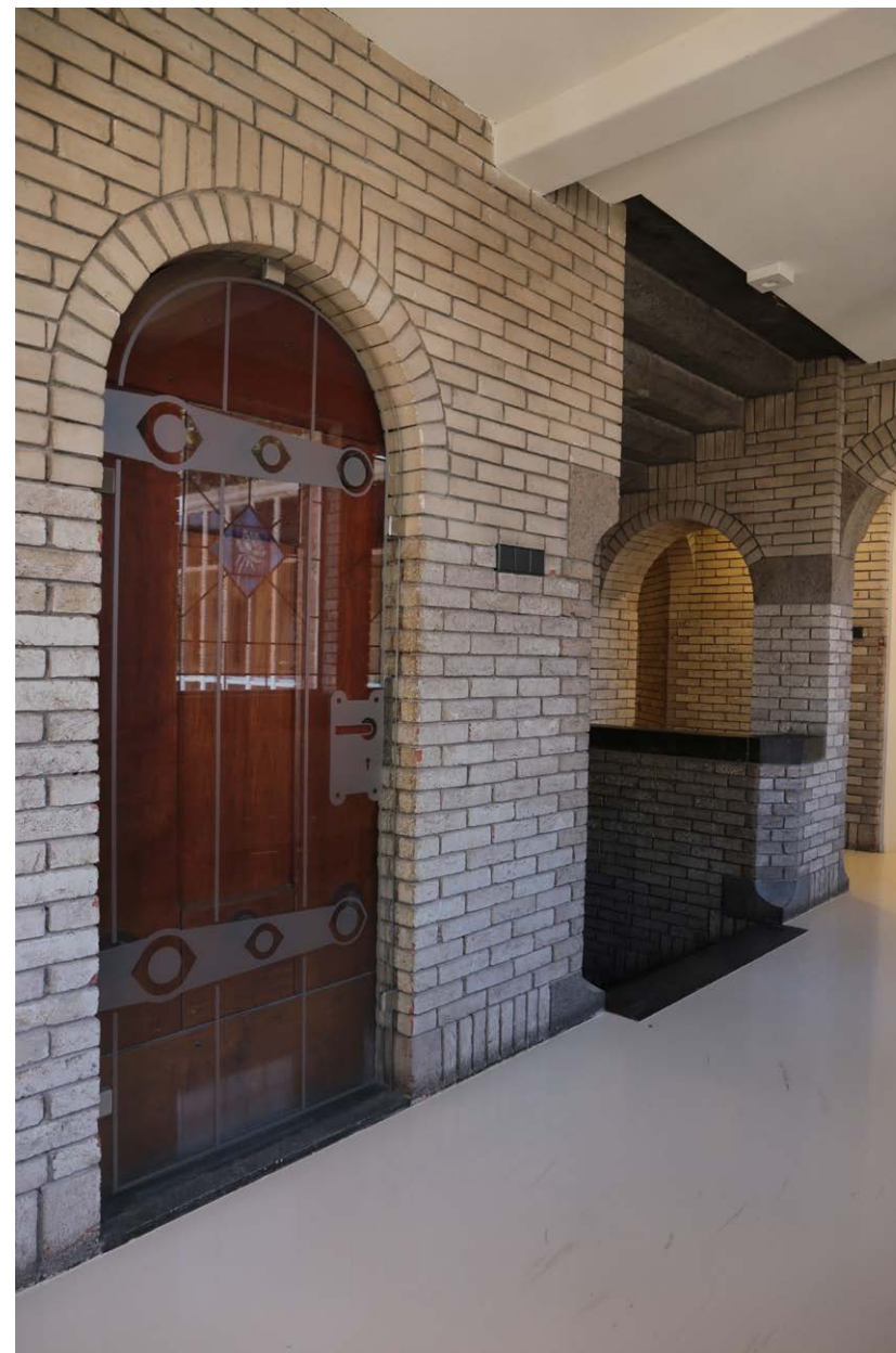
afb. 25: Het muurwerk in de zone achter het trappenhuis is uitgevoerd in lichte stenen, deels geglazuurd. De witte vloer en de glasplaat voor de deur dateren van 2015.
