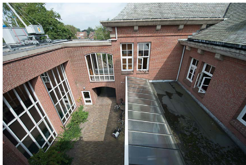
afb. 119: gevel kleine binnenplaats 2012
