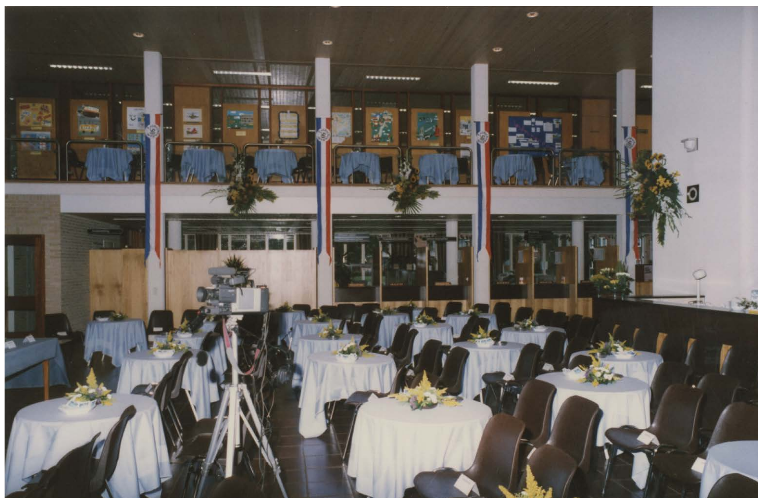
afb. 103: 1988, interieur grote hal: houten plafond, balustraden van gebogen buis, stalen kolommen (zicht richting achtergevel) [2].
