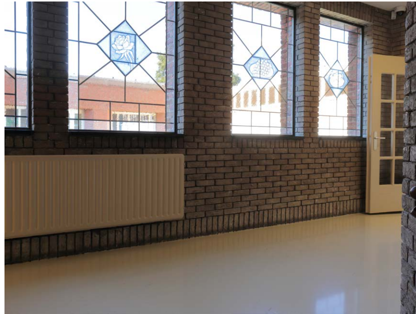
afb. 140: Gang raadhuis, tweede verdieping. Nieuwe witte vloer. De oorspronkelijke glas-lood-ramen hebben een opvallend grote transparantie.
