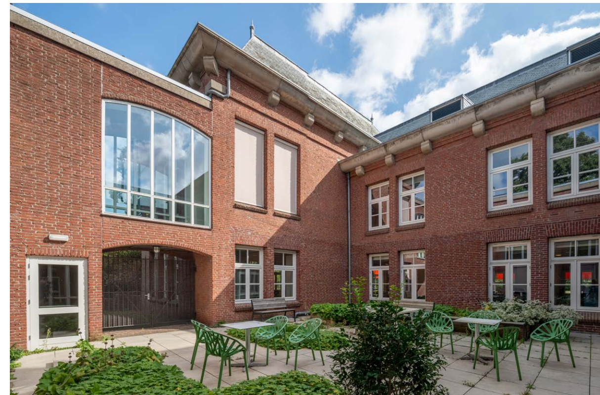
afb. 125: de kleine binnentuin, na afbraak van het lage bouwdeel uit 1981. Het nieuwere metselwerk is iets donkerder.
