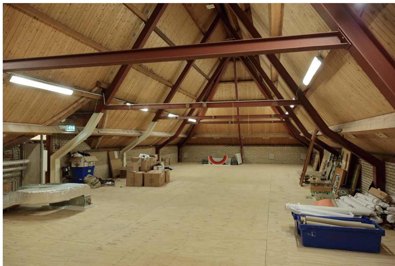
afb. 99 - Zolder rechter vleugel, met stalen spanten.
