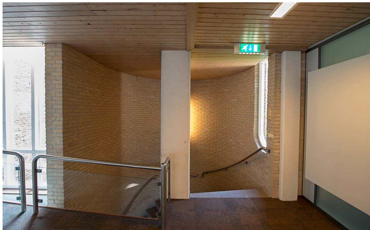
afb. 93: Zicht op één van de twee halfronde trappenhuizen van Kranendonk (foto uit 2012)
