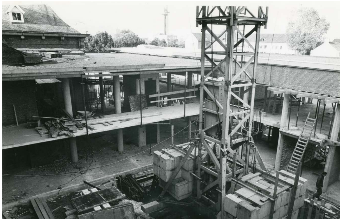
afb. 90: 1980 bouwplaats. [2] De kraan staat in de toekomstige grote binnentuin.
