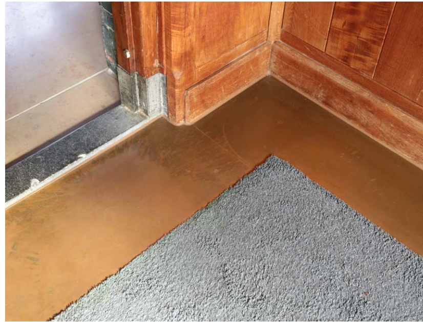
afb. 141: in een aantal kamers zijn de vloerafwerkingen vervangen door messing randen rondom vast tapijt.
