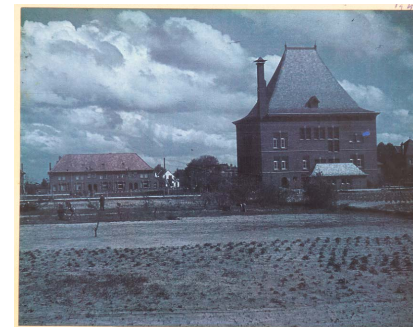
afb. 17: Zicht op de achtergevel, met een ook door Kropholler ontworpen huizenblok links. 1946 [3]
