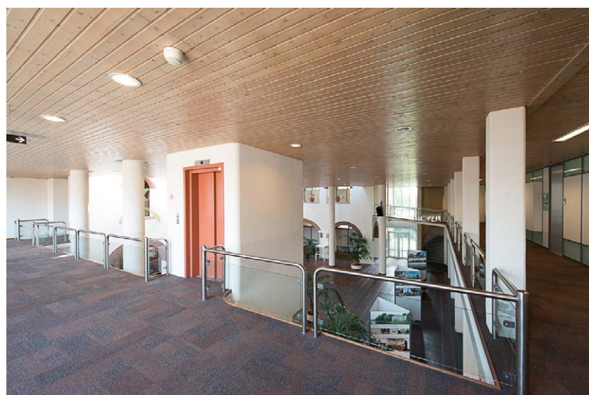
afb. 137: 2012 - de lift in de hal, en de onbektelede kolommen, uit 1981
