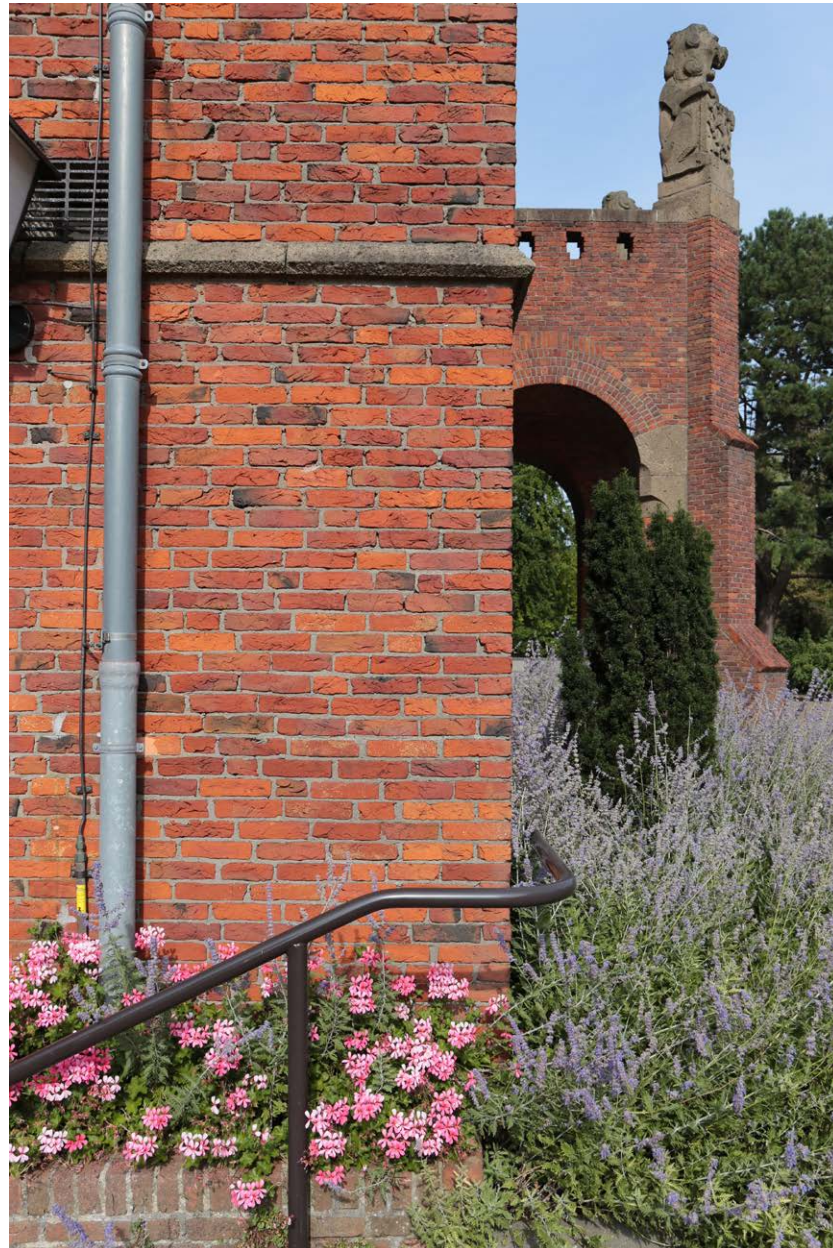
afb. 24: kenmerkend metselwerk: handvorm stenen, in wild verband
