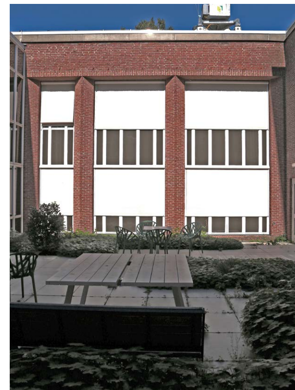
afb. 127: 2023. In het verlengde hiervan: de kolommen uit 1981, aan de kleine binnenplaats
