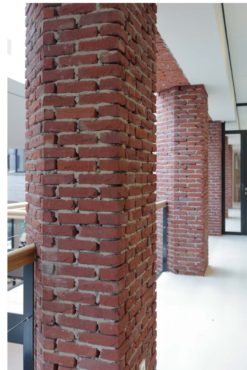
afb. 132 - metselwerk uit 2015 rond de kolommen
