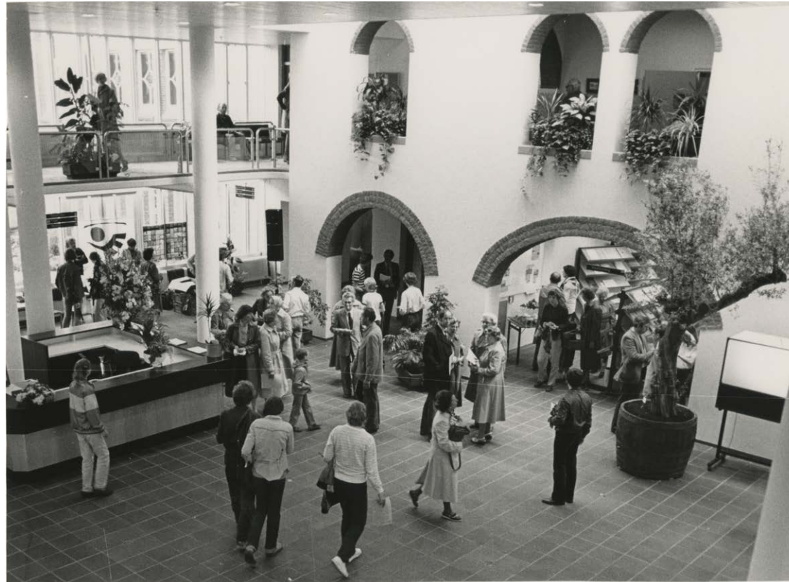
afb. 105: 1981 interieur grote hal [2]. Plavuizen, gestuukte wanden, nieuwe getoogde open vensters en doorgangen.
