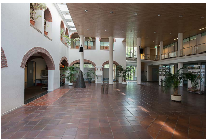
afb. 130 : 2012 - plavuizen op de vloer, houten delen aan het plafond.
