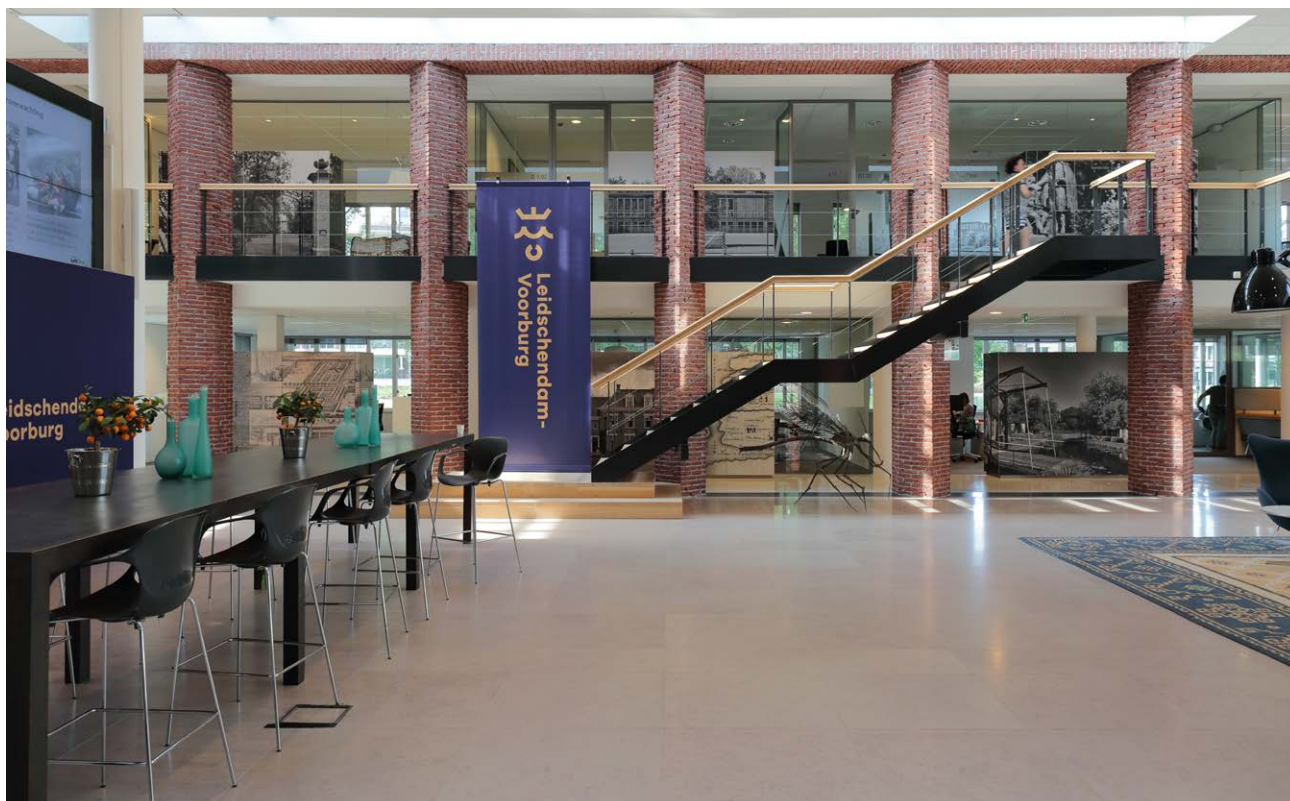
afb. 126: De kolommen in de hal zijn in 2015 omkleed met baksteen, de achtervleugel vormt nu een herkenbaar geheel.
