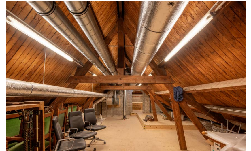
afb. 54: de kleinere kap op de verbindende vleugel tegen het raadhuis.
