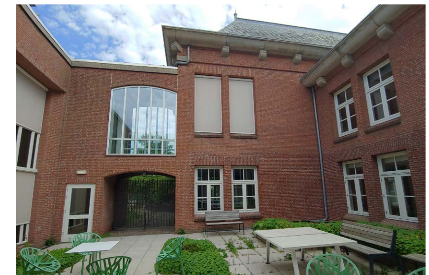
afb. 121: gevel kleine binnenplaats 20123 de laagbouw is afgebroken, de gevels zijn daar op de begane grond opnieuw opgetrokken.
