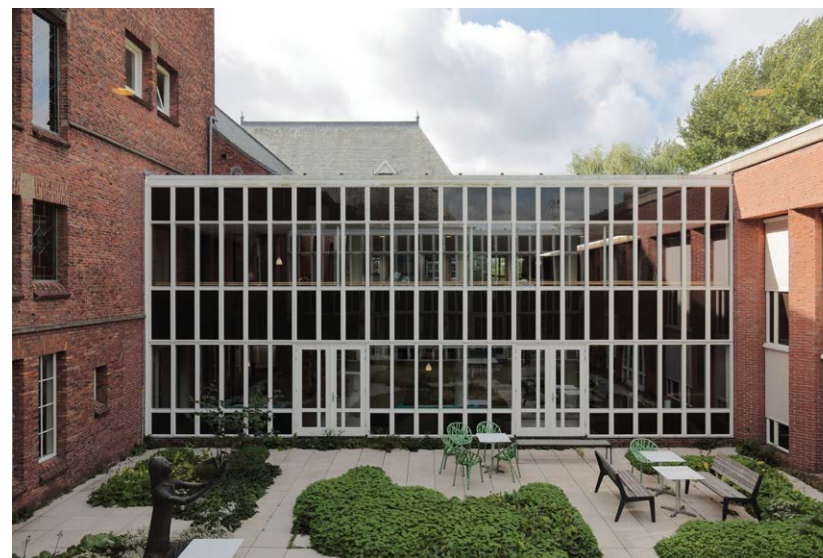
afb. 118: Binnentuin 2023. De pui is vernieuwd cf. het bestaande ontwerp.
