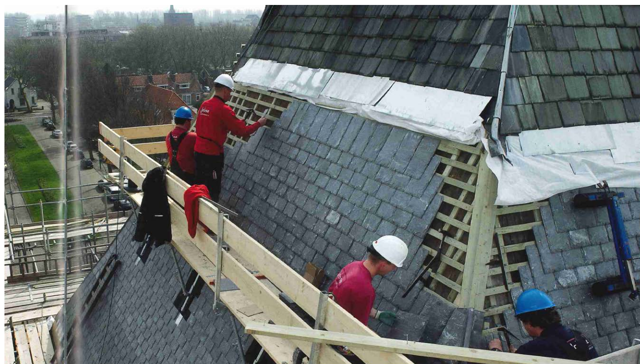
afb. 122: Vervangen van de leien. De nieuwe leien zijn blauwer van kleur dan de originele leien die een groene tint hadden. [4]
