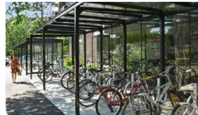
Grote centraal overdekt fietsenstalling
