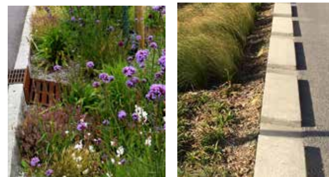
Regenwater via aflopende rand naar groene infiltratiestrook geleid
