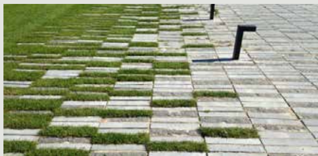
Directe waterinfiltratie in grond door (half-) bestrating
