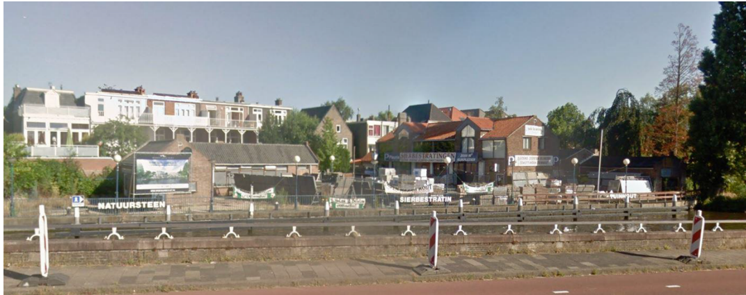
Aanzicht bestaande situatie vanaf de Vliet
