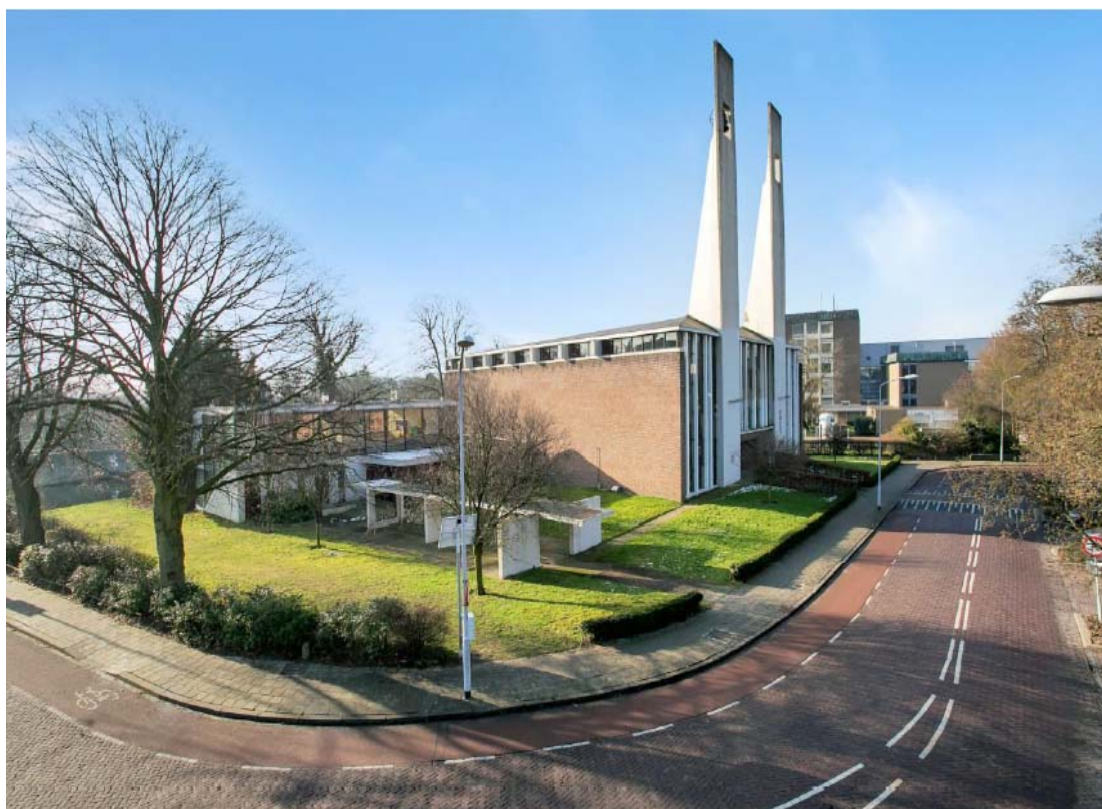
Afbeelding 11: de bestaande bebouwing gezien vanuit de noordoostzijde (Westeinde) met links (in 2 bouwlagen) de te slopen vleugel met daarvoor de eveneens te slopen gebouwde fietsenstalling
