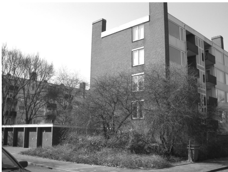
Foto 29: Kop complex Mgr. Van Steelaan, locatie lift.
