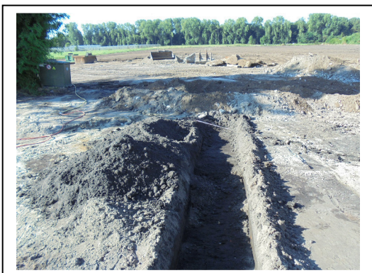
Opname van sleuf 5
