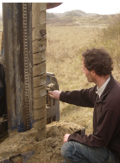
Afb. Zetten van een boorstaat
